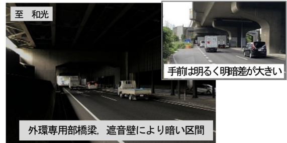
図-6 遮音壁等により明暗差が強く感じられる閉塞空間
