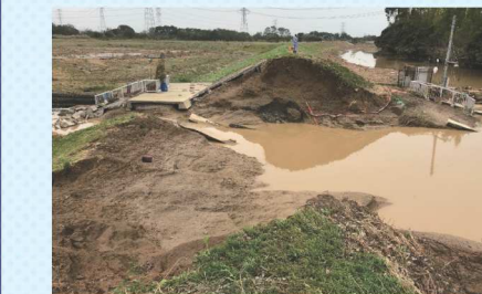
堤防が決壊した様子 ※洪水が落ち着いてから撮影しています
