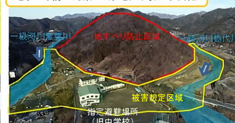
地すべり防止対策 五条地区(身延町常葉)
