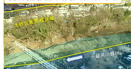
急傾斜地崩壊対策 丸林地区(甲州市大和町)
