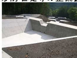
塩島沢堰堤群（富士川砂防事務所）
