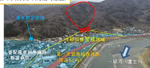
土石流対策 下天神沢川(身延町飯富)
