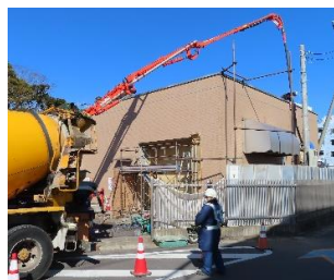
耐水化の施設扉設置工事を実施
