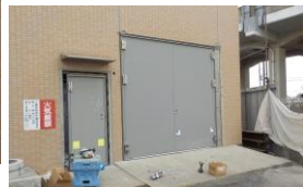
施設鋼製扉の取付完了
