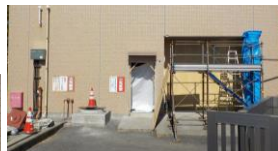
施設鋼製扉の施工状況
