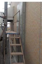
施設鋼製パネルの取付完了
