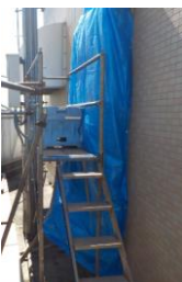
施設鋼製パネルの施工状況
