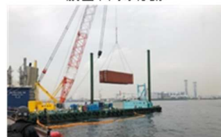
海底障害物の撤去
