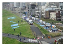
排水ポンプ車の設置
