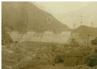
昭和28年(工事中)
