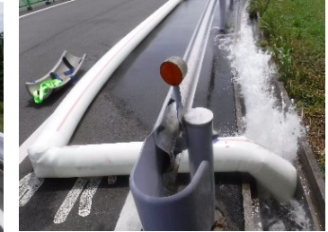
排水状況(5.0m 3 /分ポンプ)
