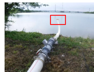
ポンプ設置状況(5.0m 3 /分ポンプ) 【ケースB】
