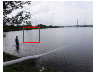
ポンプ設置状況(7.5m 3 /分ポンプ) 【ケースA】
