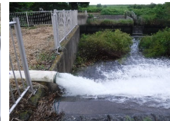
排水状況(7.5m 3 /分ポンプ)
