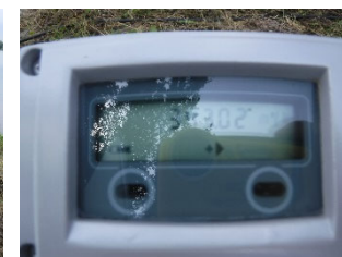
流量計表示(343m 3 /h(5.7m 3 /分)) ※5.0m 3 /分のポンプ1台使用
