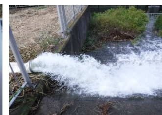
排水状況(5.0m 3 /分ポンプ)
