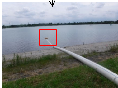
排水ポンプ設置状況
