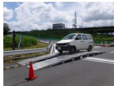
ホースブリッジ設置状況
