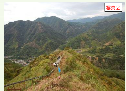
写真2 日光市 R2松木山腹工(大畑沢)工事 《足尾の荒廃地域の保護を行います》
