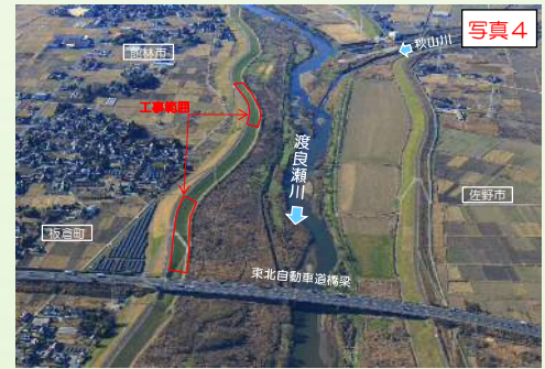
写真4 板倉町 R2渡良瀬川右岸西岡新田地先高水護岸工事 《堤防に護岸の整備を行います》
