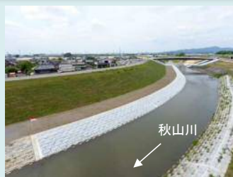
H30秋山川大古屋地先護岸他工事
