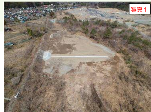
写真1 みどり市 R1花輪4号帯工(右岸)工事 《土砂の移動を防ぐための帯工の工事を行います》
