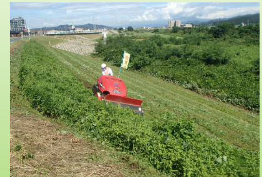
河川維持修繕工事 《堤防除草や河川管理施設の維持修繕及び洪水、地震時の状況把握業務を行います》
