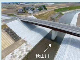
H30秋山川大古屋地先護岸他工事
