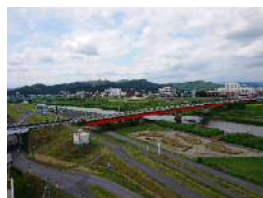
事務所屋上から上流方面
