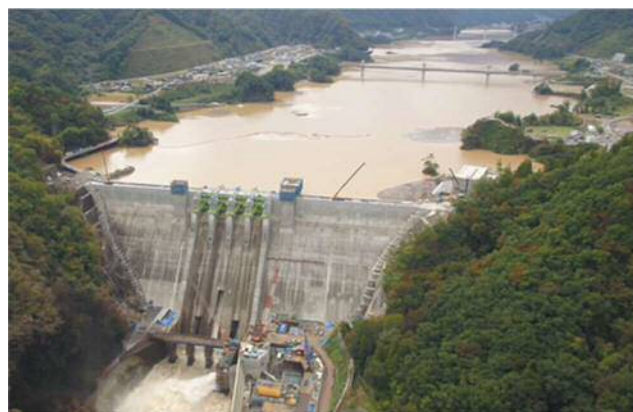
図-2 ハッ場ダム試験湛水(満水)
