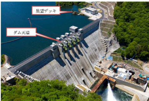
図-3 ハッ場ダム屋外開放範囲（令和2年7月時点）
