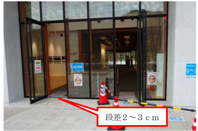
図-6 資料館湖面側出入口（対策前）
