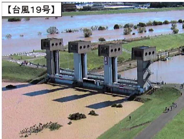
写真1 東日本台風時の岩淵水門
