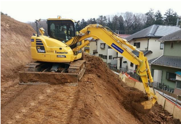
図-7 MCバックホウによる掘削
