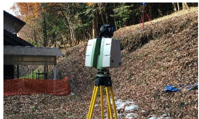
図-4 TLSによる起工測量
