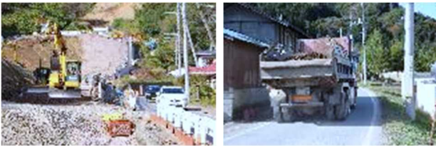
図-2 町道新井横谷松谷線の車両通行状況
