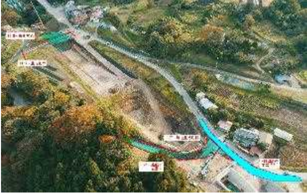
図-6 工程会議における規制状況の共有例
