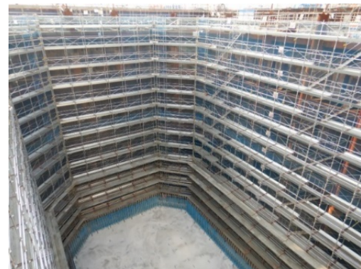
写真-1 躯体構築用足場設置の様子
