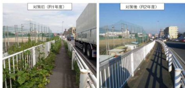
図-1 5 歩道の対策状況
