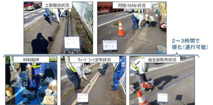
図-12 ウィードコート工法の施工状況
