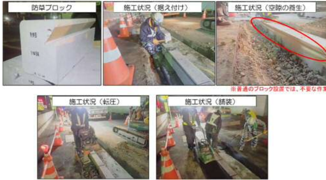
図-9 防草ブロック設置状況
