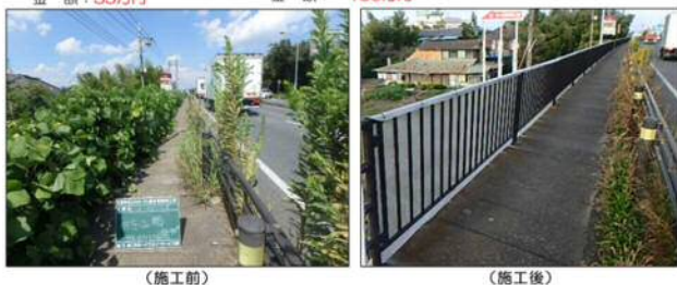
図-1 4 つるガード工法の実施結果
