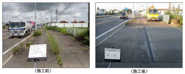
図-13 ウィードコート工法の実施結果
