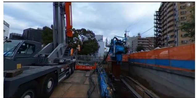
図-3 360°カメラ（杭施工側）
