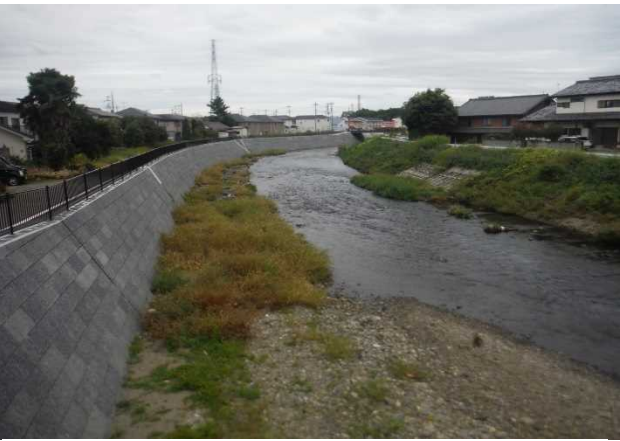
図-7 護岸の露出範囲を減少させ景観性が向上した状況
