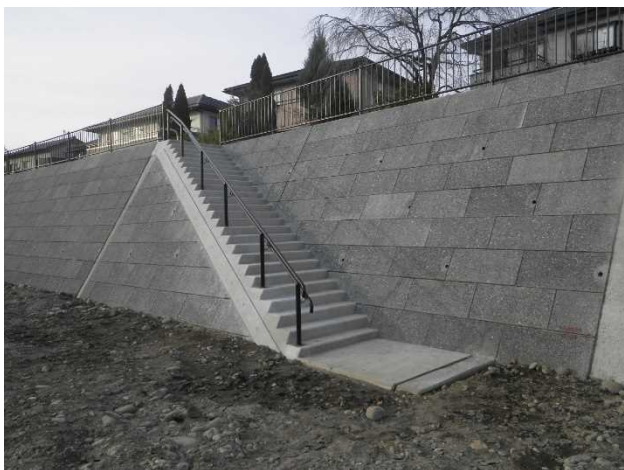
図-12 階段工の設置
