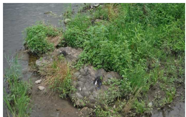
図-5 袋詰め玉石から繁茂植生
