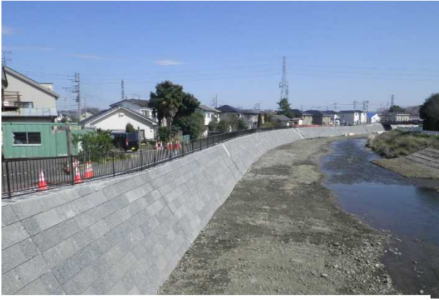
図-6 みお筋を保全し、水際部を形成した施工状況
