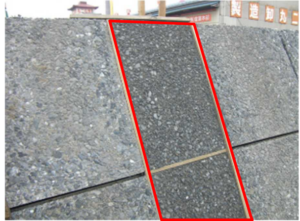
図-9 目地の洗い出し状況
