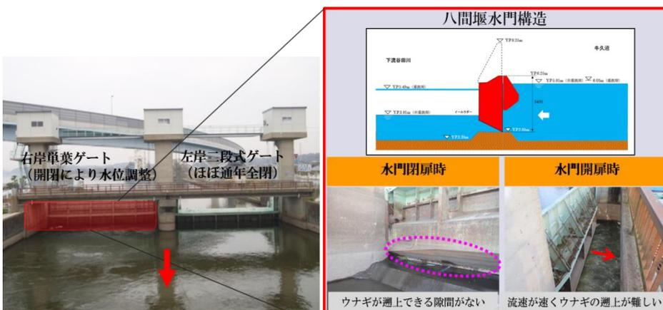
写真-1 八間堰水門の構造
