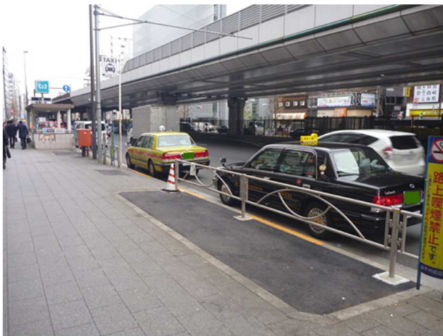
図-3 撤去された植栽帯（植栽から舗装に変更）
