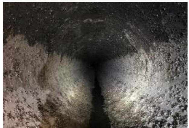
図-2 北千葉導水路の管渠内に付着するカワヒバリガイ
