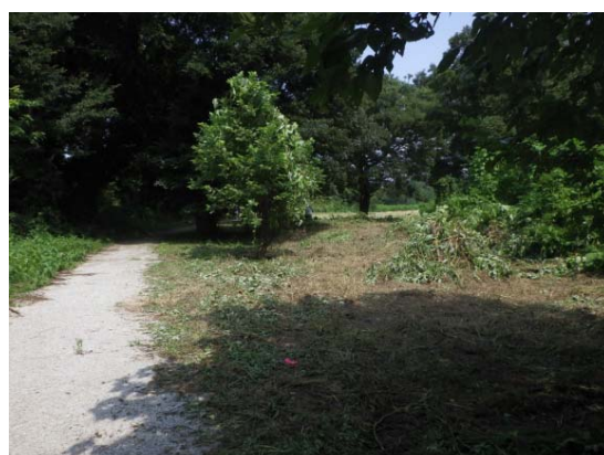
中池通路の作業後
