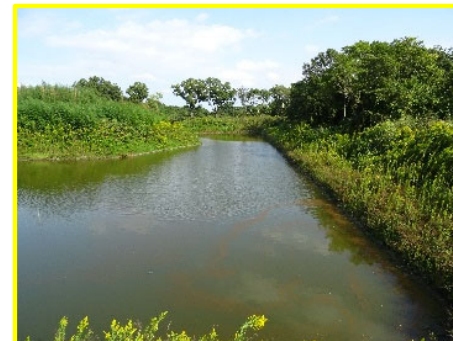
⑤水位が高く当面見守る箇所
