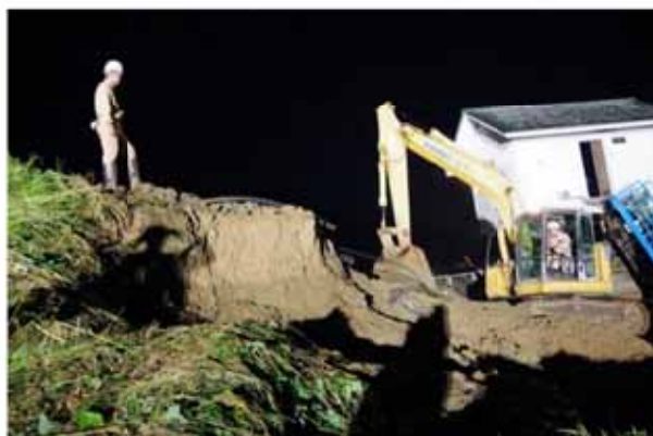
球磨川 堤防決壊箇所の緊急復旧（熊本県人吉市）
