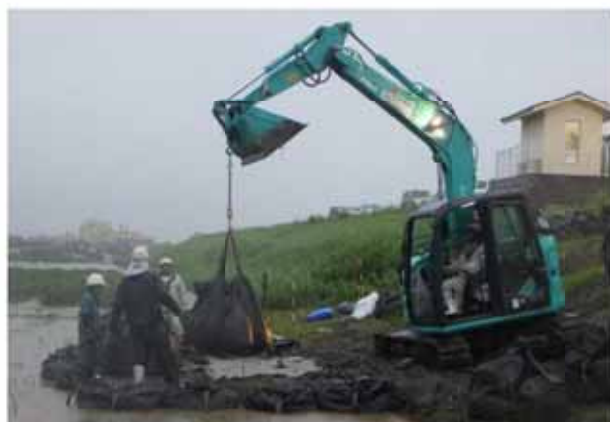
筑後川 川裏漏水箇所の応急対策 （福岡県久留米市）
