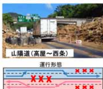
＜区域外からの土砂等流入による被災状況＞ ＜片側一車線での物資輸送車両の通行状況＞
