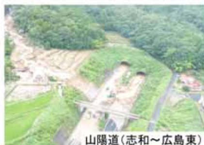
＜区域外からの土砂等流入による被災状況＞ ＜片側一車線での物資輸送車両の通行状況＞
