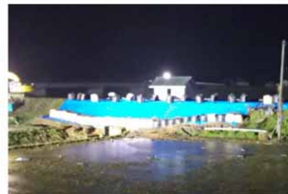
緊急復旧完了
