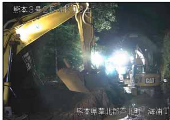
国道3号 海浦トンネル付近の道路啓開 （熊本県芦北町）
