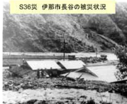
S36災 伊那市長谷の被災状況
