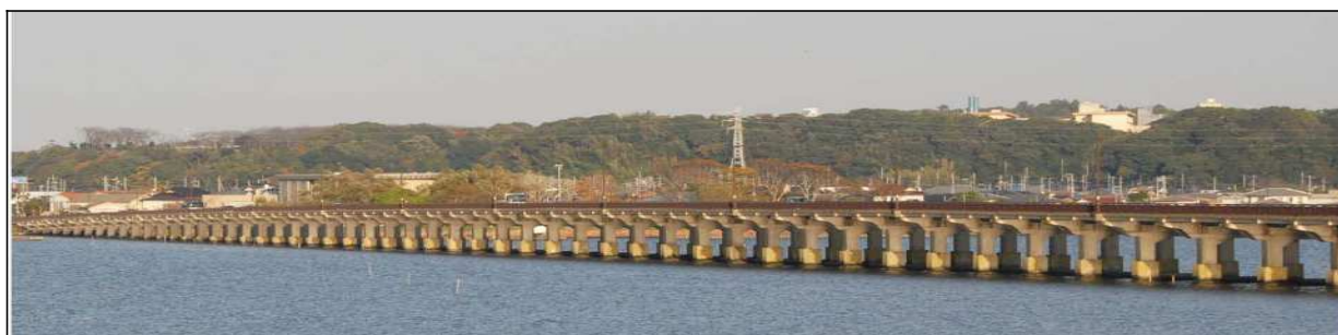
写真 2.1 神宮橋の全景（潮来市側→鹿嶋市側望む）
