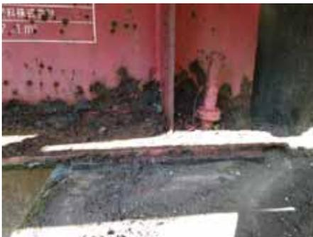
桁端が腐食している
