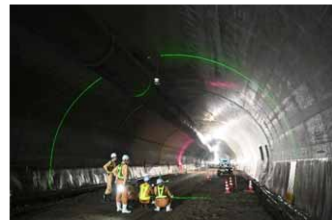
トンネル3次元計測の様子
