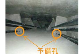
新設橋にて、ケーブル交換、追加用の予備孔を設置
