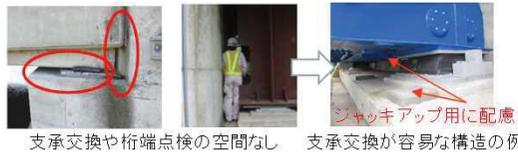
支承交換や桁端点検の空間なし 支承交換が容易な構造の例
