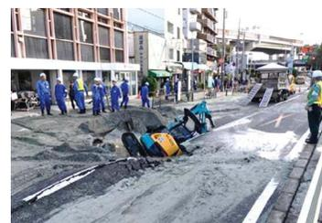
埋設管の老朽化に伴う道路陥没
