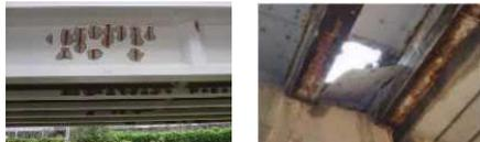
コンクリートの保護塗装後に剥離した例 鋼板接着により補強されたコンクリート床版が抜け落ちた例
