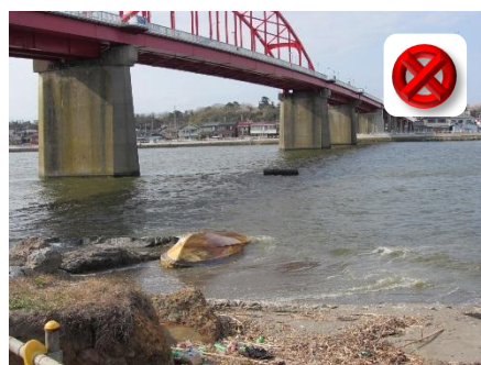
出水により流出した船舶
