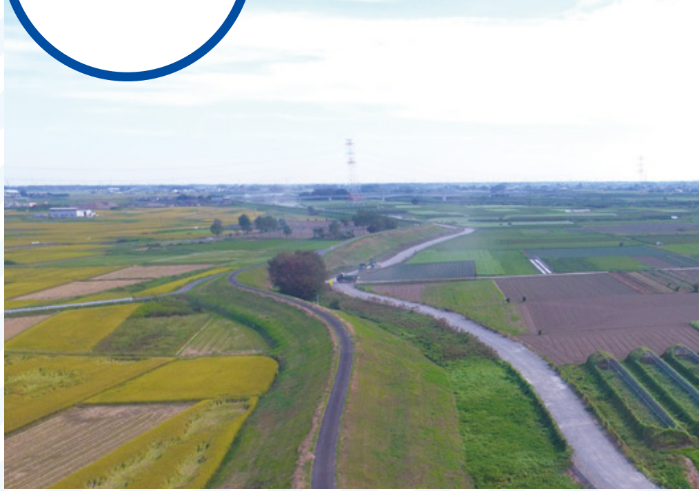
【施工前】2019年10月8日
