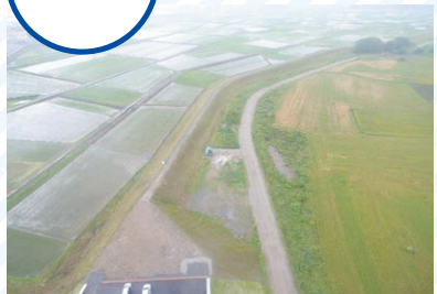
【施工前】2020年6月2日
