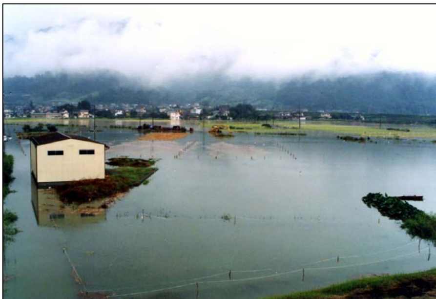
写真-1.2.9 市川三郷町高田地区(鳴沢川)の浸水状況 ＜平成3年9月洪水＞
