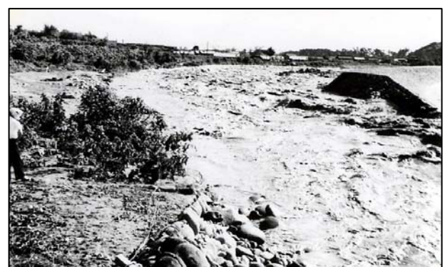
根津橋上流左岸破堤
