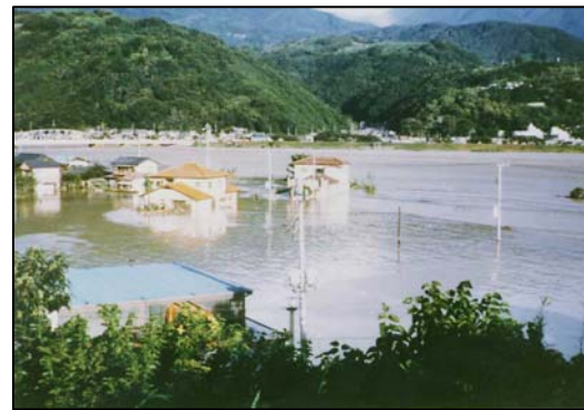
写真-1.2.5 山間狭窄部の浸水被害 ＜昭和 57 年 8 月災害 鰍沢町船場地先＞
