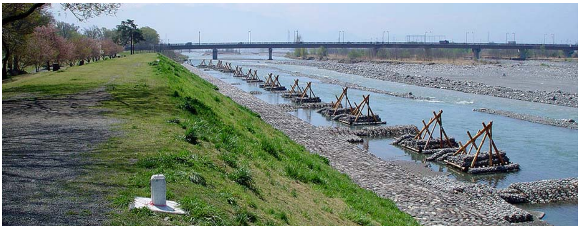
写真-2.2.1 信玄堤の聖牛及び出し（釜無川） （急流河川の伝統的治水工法）
