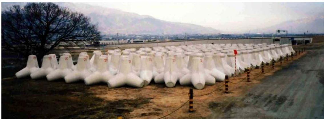
写真-2.3.10 水防資材の備蓄状況
