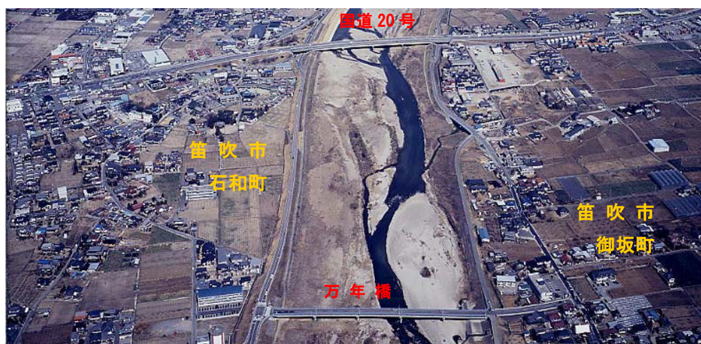
写真-1.2.10 笛吹川中流部の堤防断面不足や河床の高い区間 ＜河積の確保には築堤、河床掘削が必要＞
