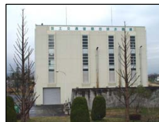
<排水機場の維持修繕> (写真は穂池排水機場)
