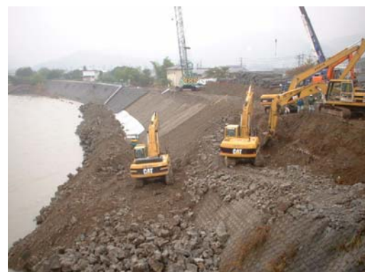
写真-1.2.7 復旧状況
