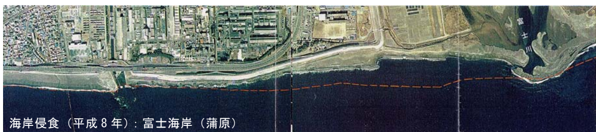
写真－1.2.22 富士海岸（蒲原）の汀線変化の状況 ＜赤色の破線は昭和22年の海岸線を示し、最大340m後退している。＞
