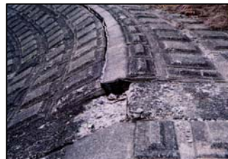
<護岸の破損>
