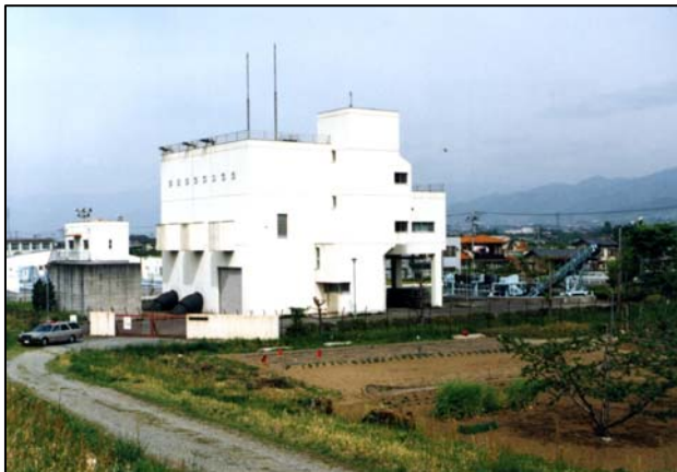
<排水機場外観>
