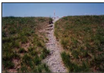
<堤防の破損>
