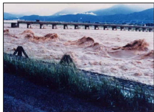
信玄橋下流地点
