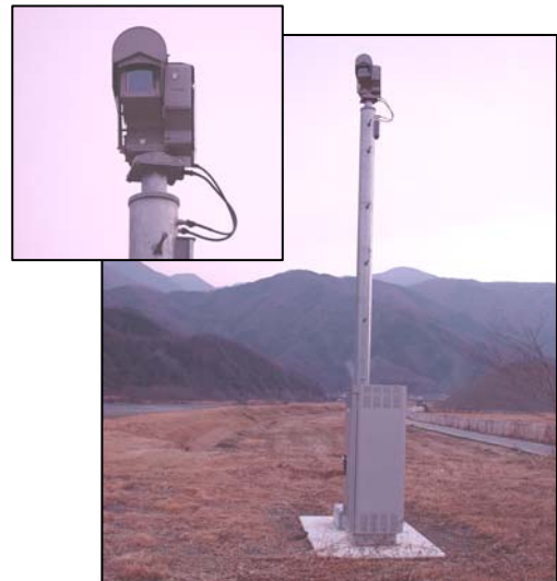
写真-2.3.2 監視用カメラ（下山）
