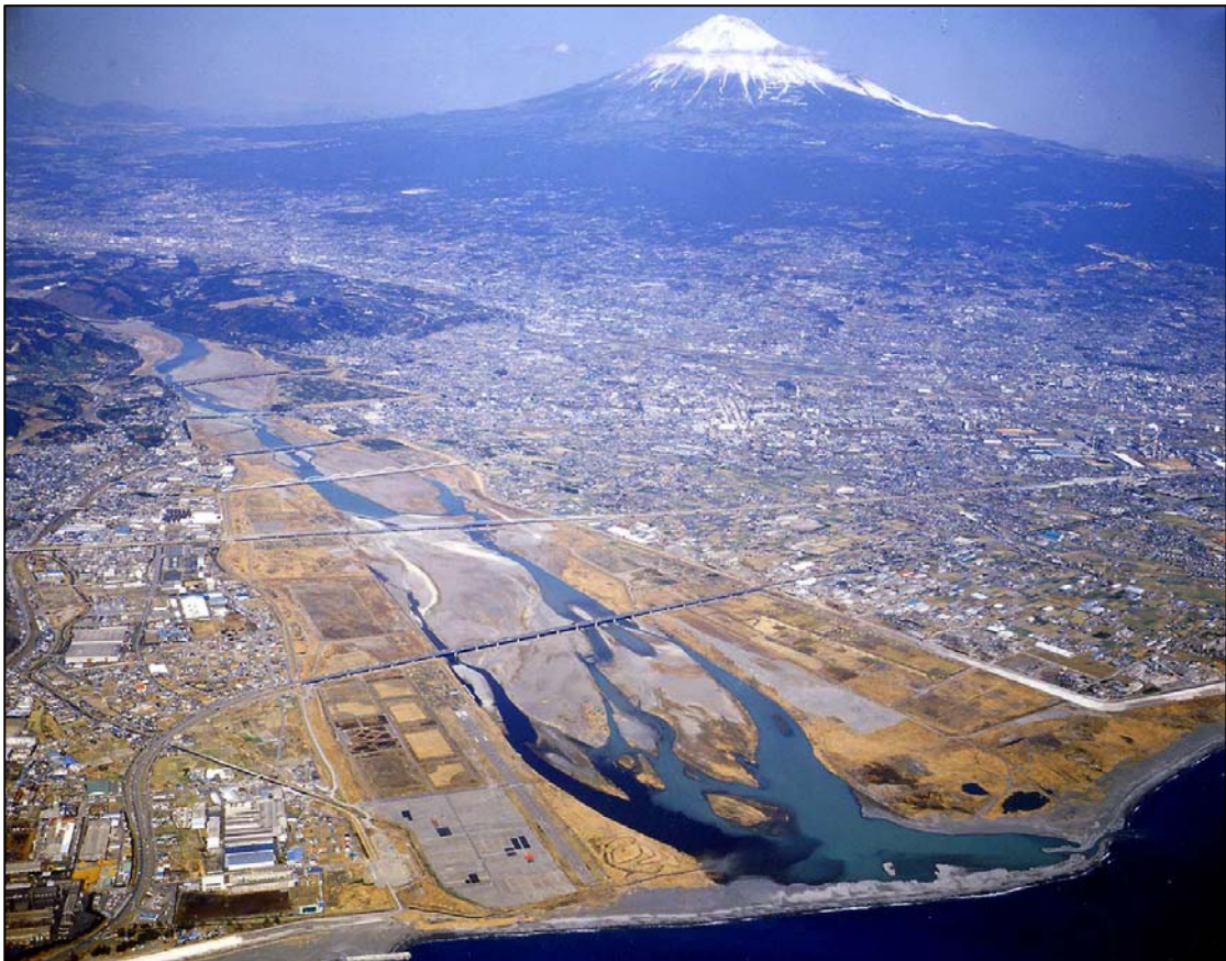
写真-1.2.3 沿川に市街地が隣接する富士川河口部 <日本一深い駿河湾に面し、高潮の影響が大きい。>
