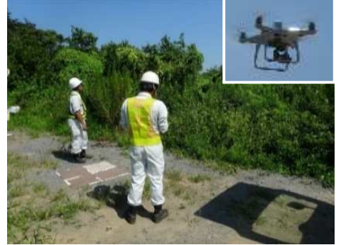
ドローンによる測量作業 常陸大宮市下伊勢畑地区 那珂川右岸41.0k付近
