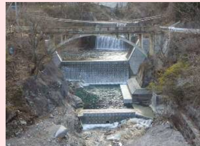
H30 餅ヶ瀬川一号砂防堰堤改築工事
