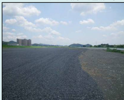
H30・31五十部地先高水敷整備工事
