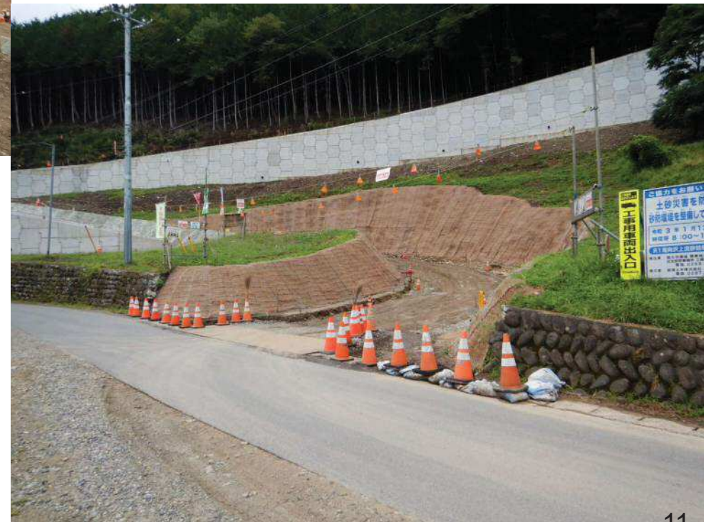
施工状況(管理用道路)
