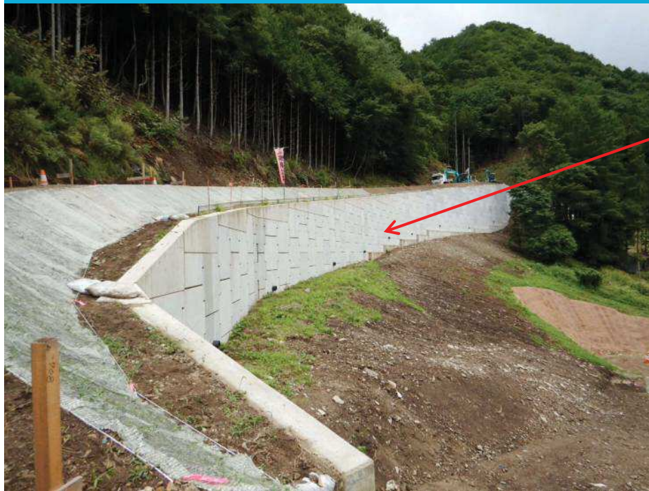
施工状況(管理用道路)
