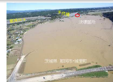
那珂川における浸水被害状況
