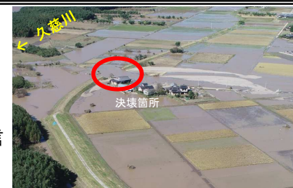
久慈川における浸水被害状況
