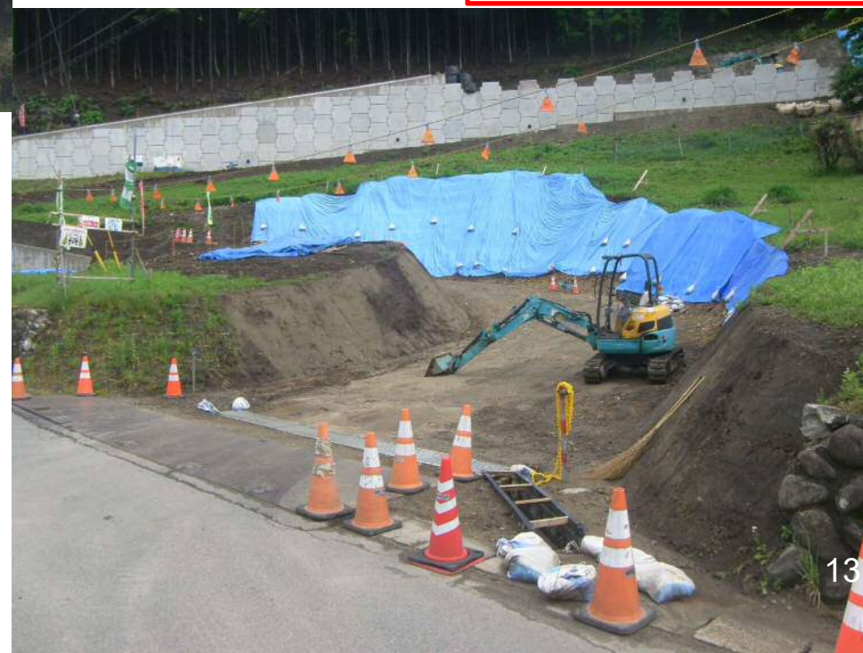
施工状況(管理用道路)
