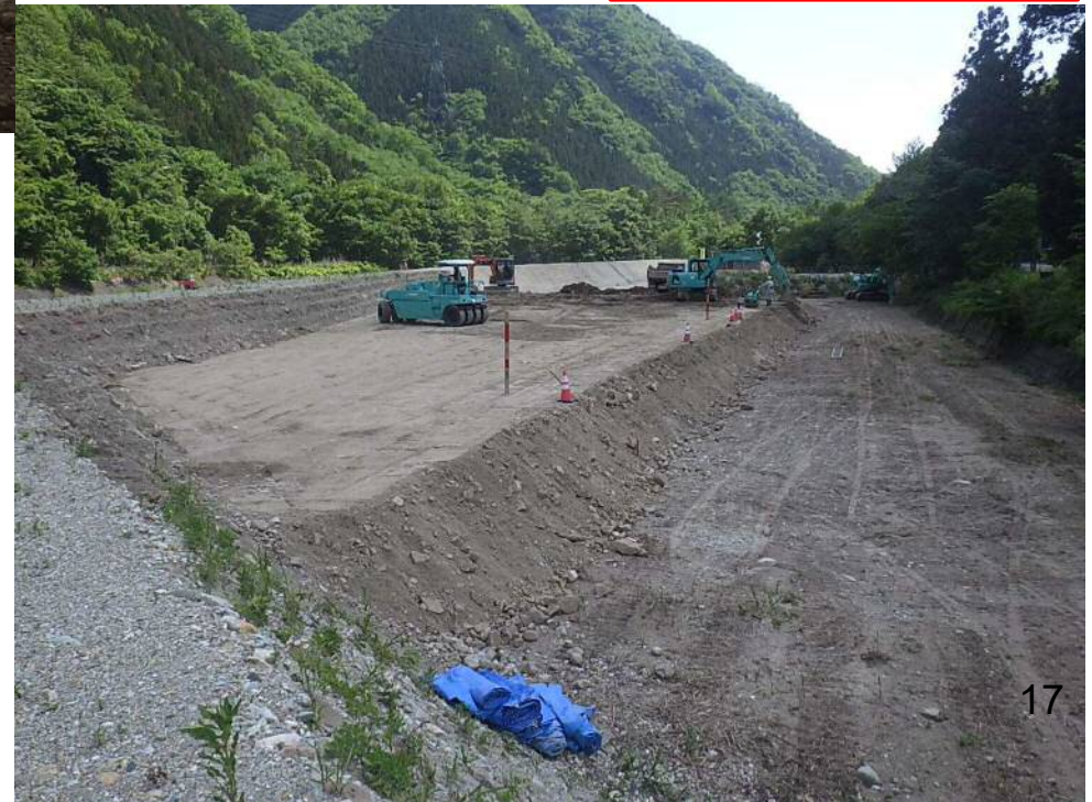
施工状況(土砂置場)
