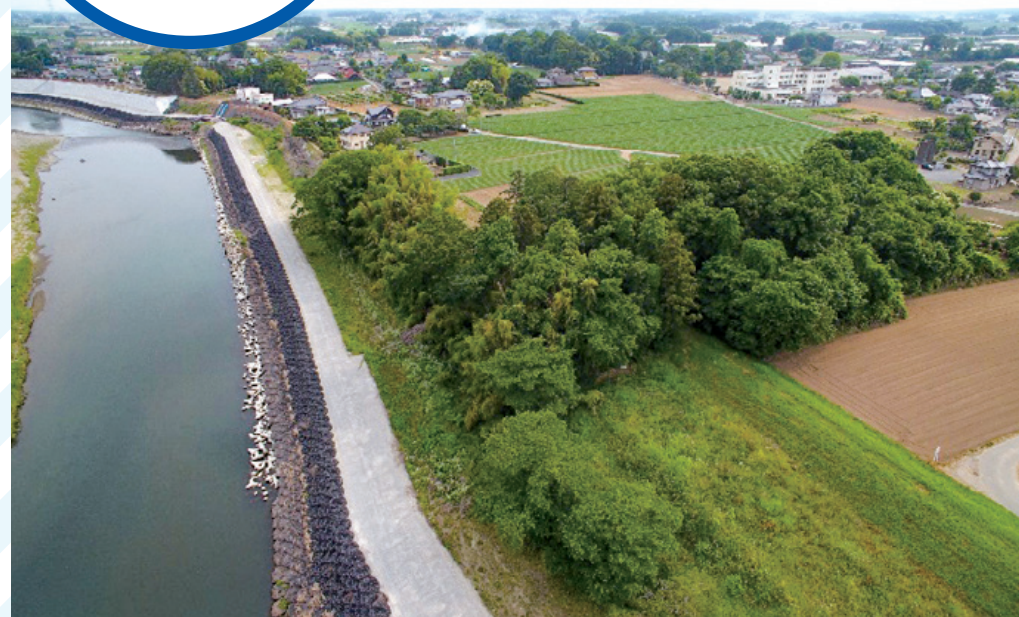
【施工前】2019年6月7日
