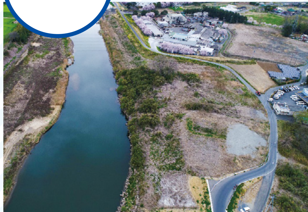
【施工前】2019年4月8日
