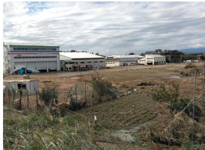
排水後(川裏) 10月15日午前
