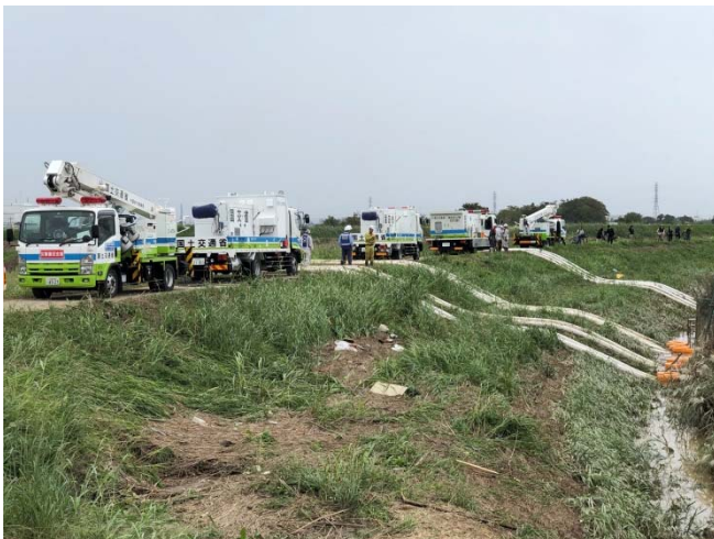
排水ポンプ車稼働状況 10月14日午前
