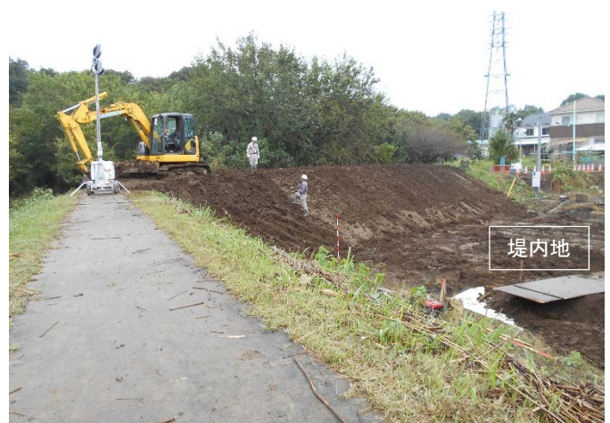
2019.10.18 11時00分時点 法面盛土整形
