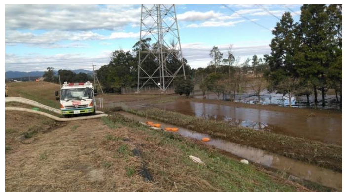
排水後(川裏) 10月15日午前
