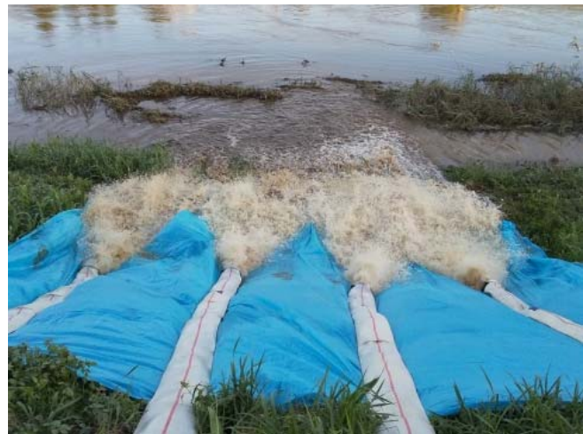
排水状況(川表) 10月13日午後
