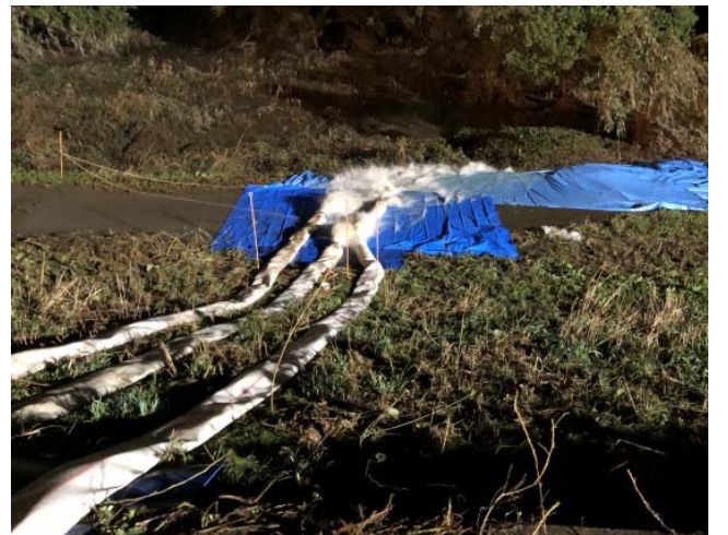
排水状況(川表) 10月14日午後
