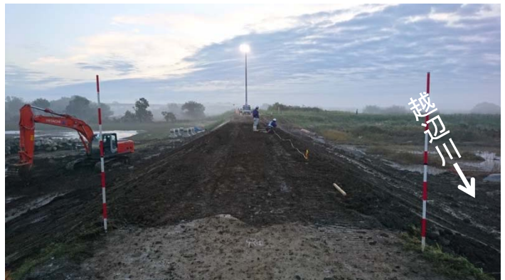
2019.10.20 8時00分時点 堤防盛土
