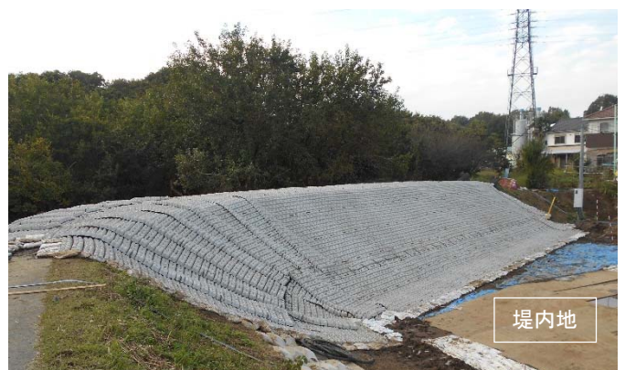
2019.10.30 17時00分時点 緊急復旧工事完了
