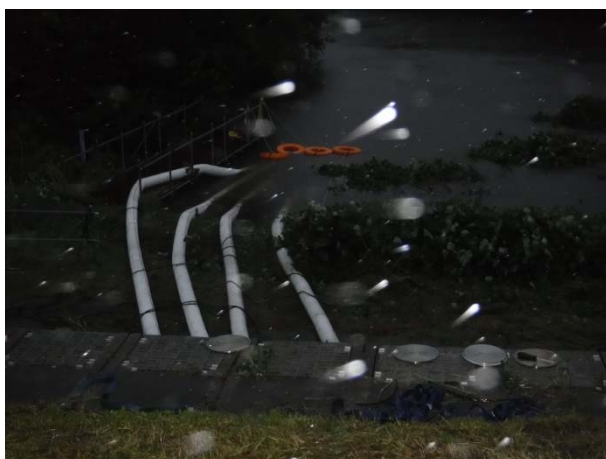
排水状況(川裏) 10月12日午後
