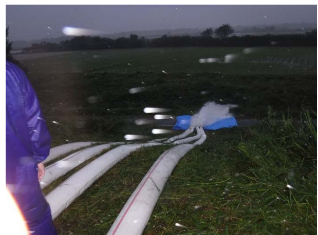
排水状況(川表) 10月12日午後
