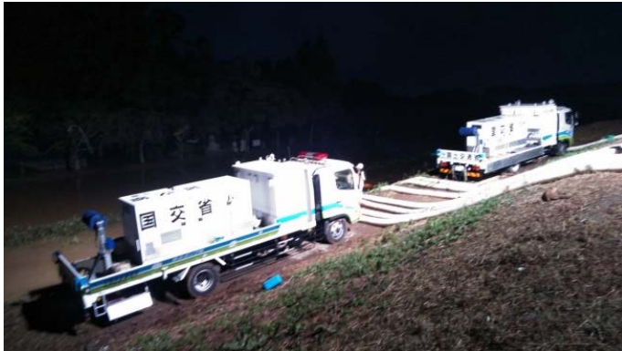
排水ポンプ車設置状況 10月14日午後
