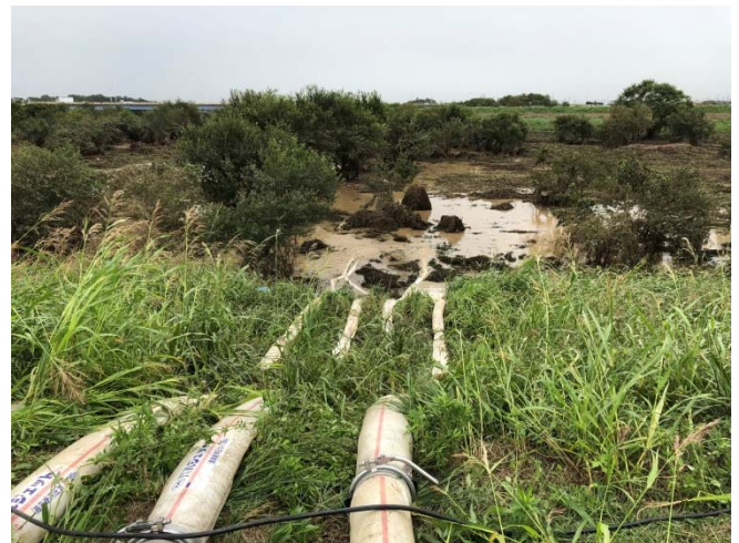
排水状況(川表(小畔川)) 10月14日午前
