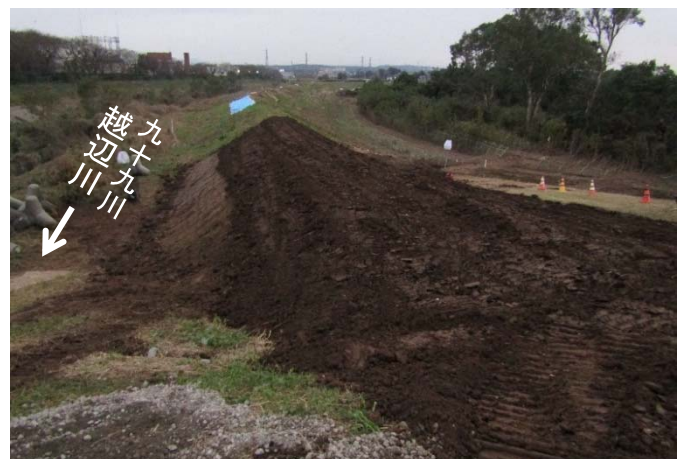
2019.10.17 8時00分時点 堤防盛土
