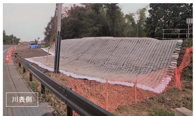
2019.10.30 18時00分時点 緊急復旧工事完了
