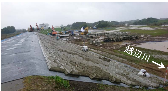
2019.10.22 8時00分時点 連節ブロック張施工中
