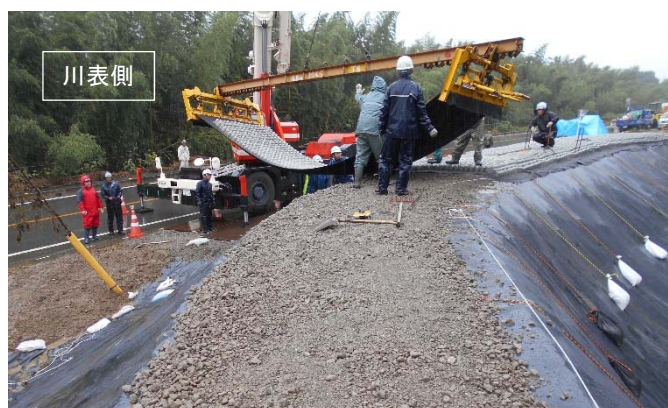
2019.10.24 11時00分時点 ブロックマット施工
