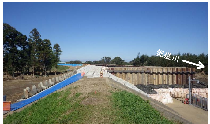
2019.11.8 13時00分時点 緊急復旧工事完了
