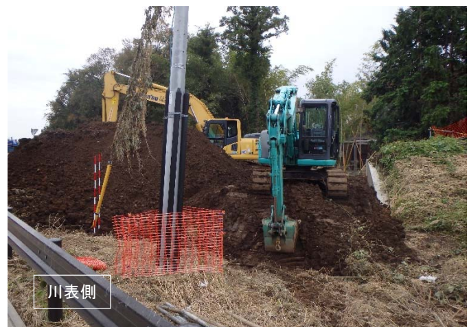
2019.10.17 17時00分時点 堤防盛土
