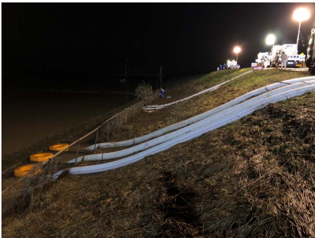
排水状況(川裏) 10月14日午後
