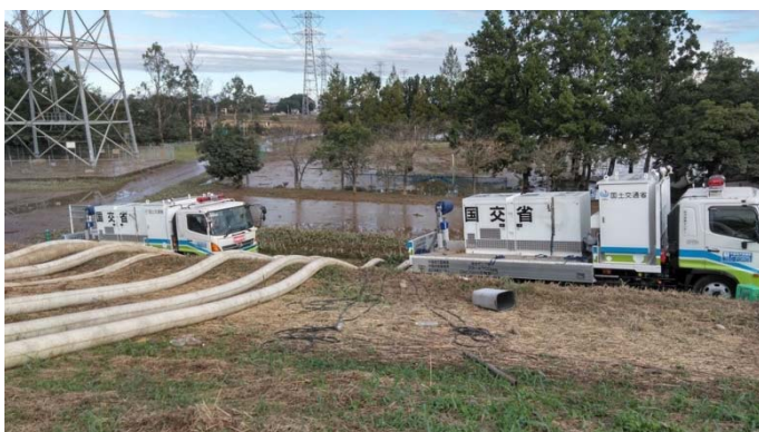
排水ポンプ車設置状況 10月15日午前
