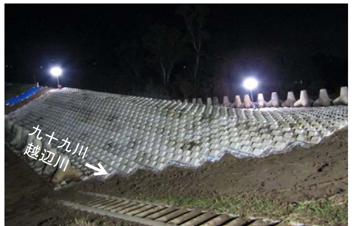
2019.10.19 21時20分時点 緊急復旧工事完了
