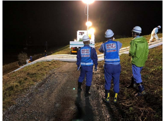
排水ポンプ車の展開状況 10月14日午後
