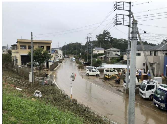
排水後(川裏) 10月14日午前
