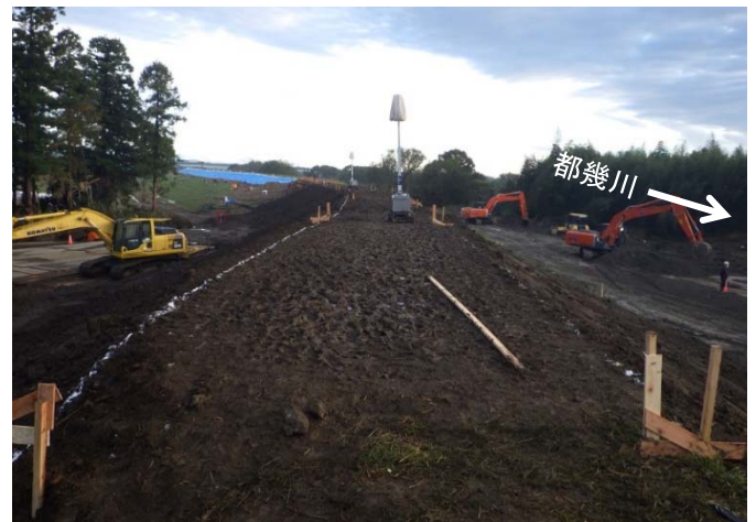
2019.10.20 8時00分時点 堤防盛土
