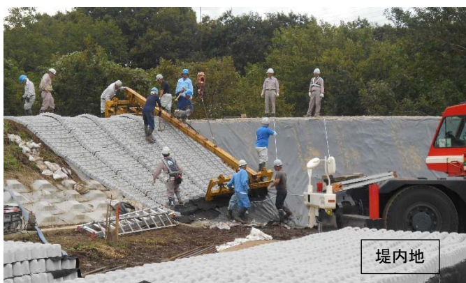
2019.10.26 10時00分時点 ブロックマット施工
