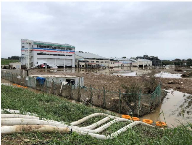
排水状況(川裏) 10月14日午前
