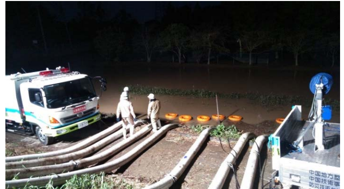
排水状況(川裏) 10月14日午後
