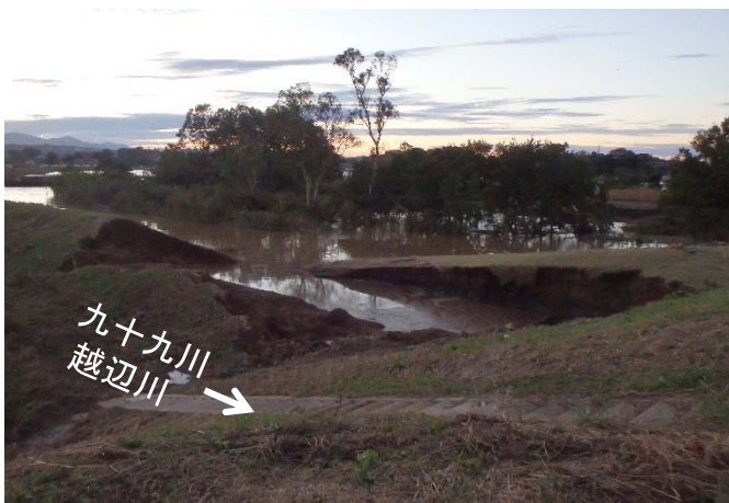
2019.10.13 17時30分時点 被災状況
