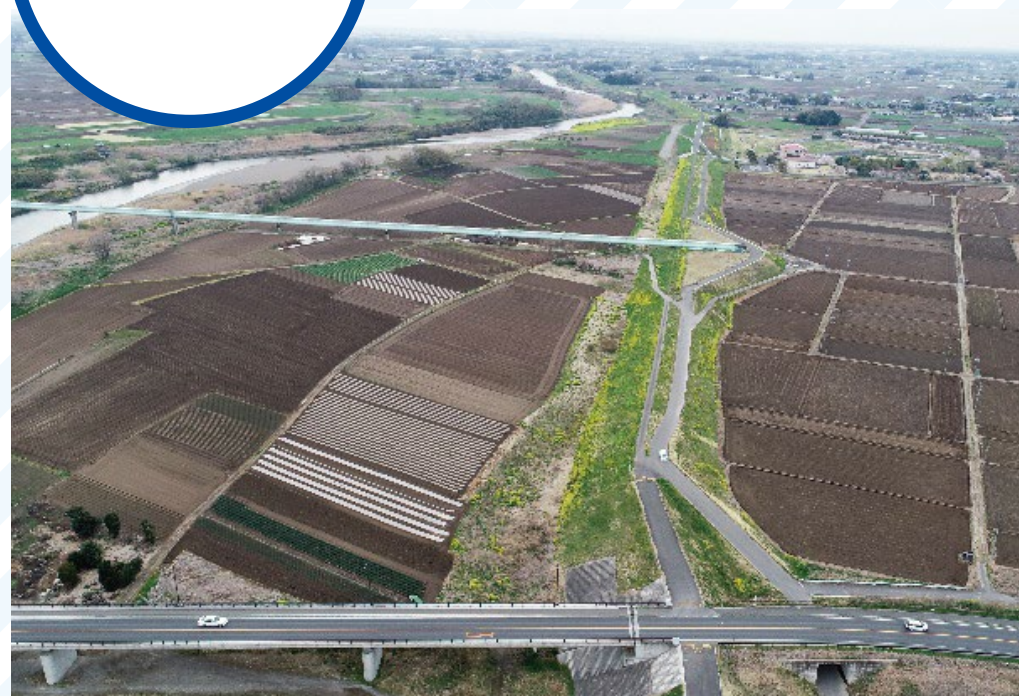
【施工前】2019年4月12日
