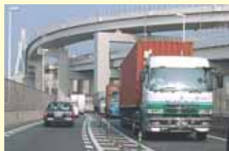
臨港道路を通行するコンテナ車両
