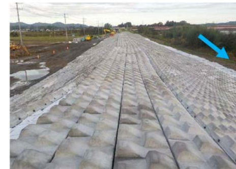
決壊地点の災害復旧工事状況 (令和元年10月洪水後)
