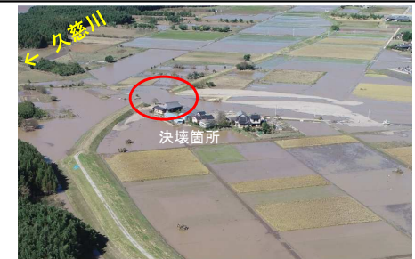
久慈川における浸水被害状況
