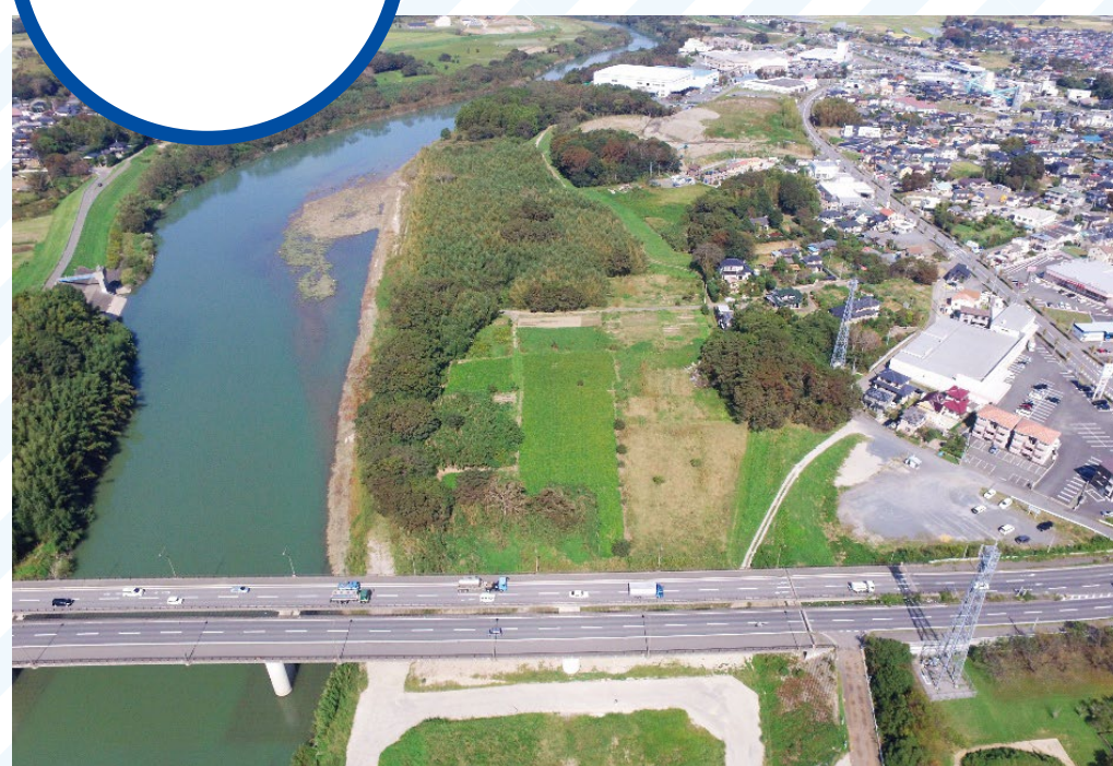
【施工前】2018年9月11日
