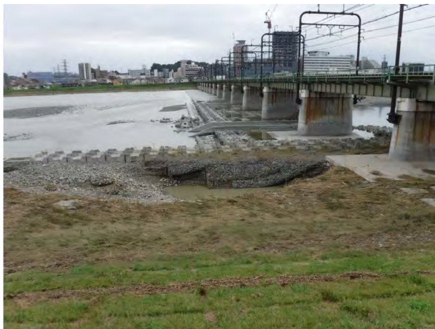
⑫多摩川 49.6k 左岸（東京都福生市） 河岸（高水敷）洗掘 L=123m
