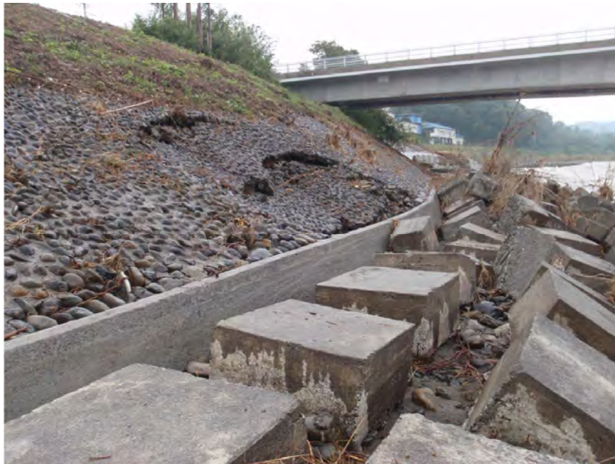
②⑩多摩川 53.2k 左岸（東京都青梅市） 護岸洗掘 L=76m
