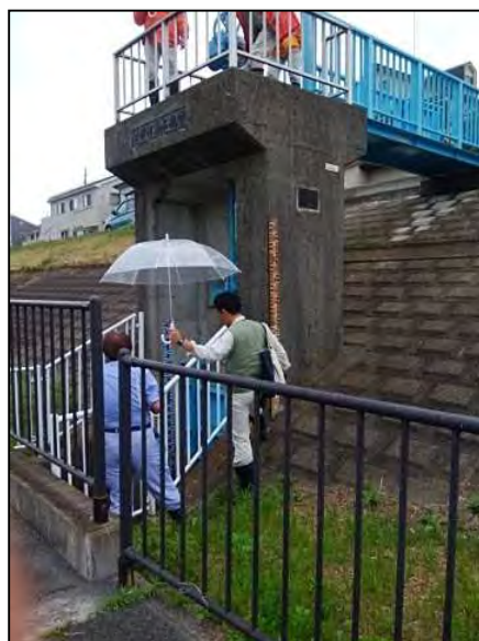
樋管の開閉状況の確認
