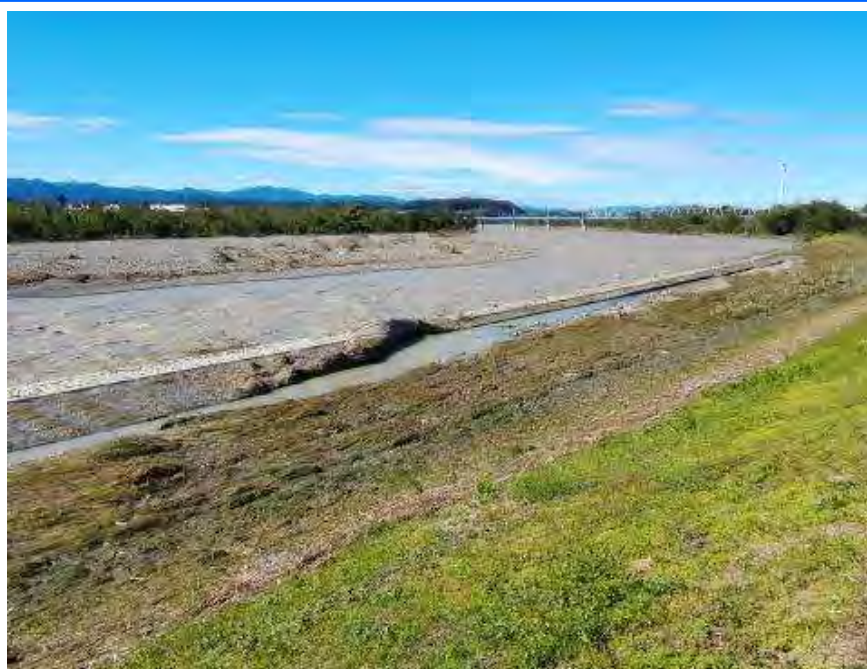
⑫多摩川 49.6k 左岸（東京都福生市） 河岸（高水敷）洗掘 L=123m
