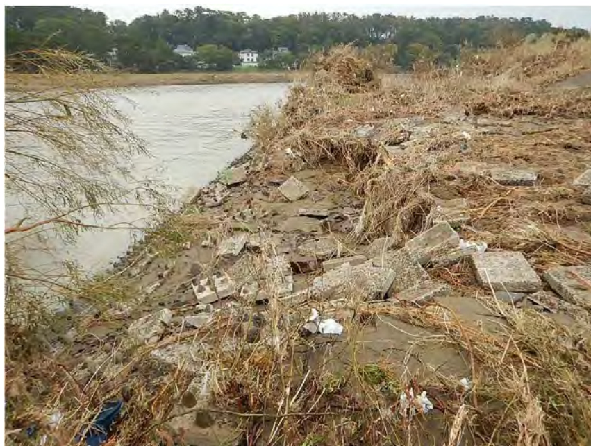
⑥多摩川 19.4k 左岸（東京都世田谷区） 低水護岸崩壊 L=91m
