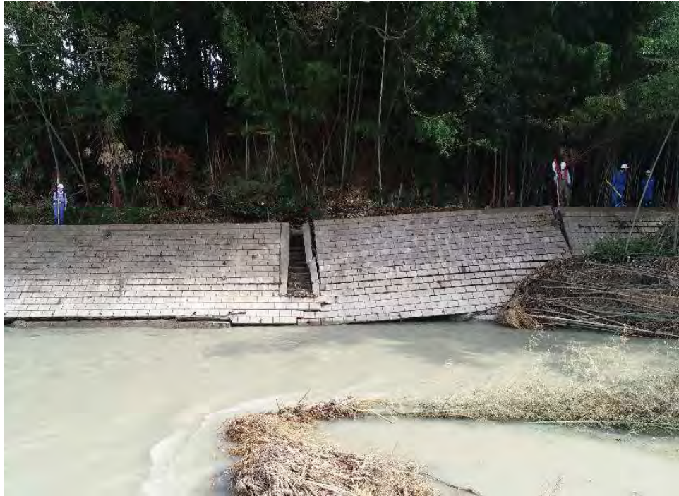
②②多摩川 58. 2k 左岸（東京都青梅市） 根固ブロック流失 L=18m
