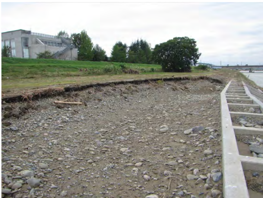
⑯多摩川 34.4k 右岸（東京都多摩市） 河岸（高水敷）洗掘 L=120m
