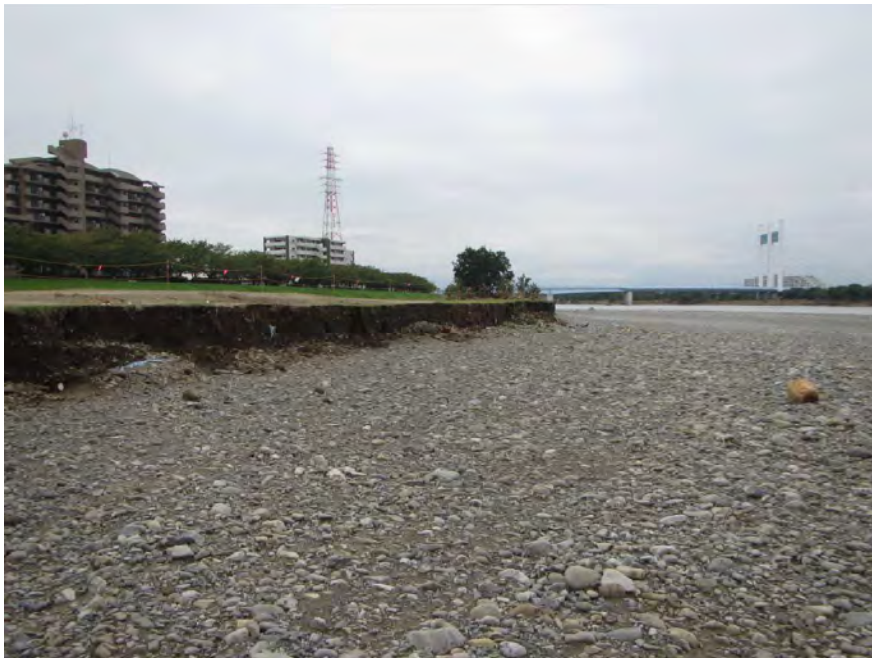
⑯多摩川 34.4k 右岸（東京都多摩市） 河岸（高水敷）洗掘 L=120m
