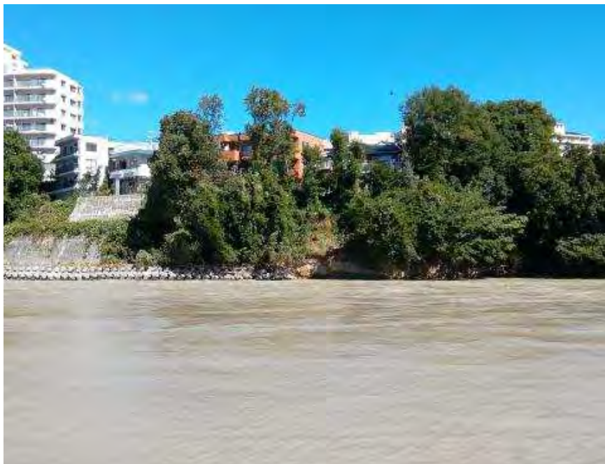
②②多摩川 58. 2k 左岸（東京都青梅市） 根固ブロック流失 L=18m
