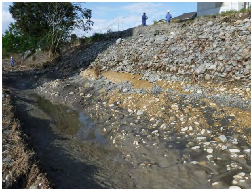
②⑩多摩川 53.2k 左岸（東京都青梅市） 護岸洗掘 L=76m
