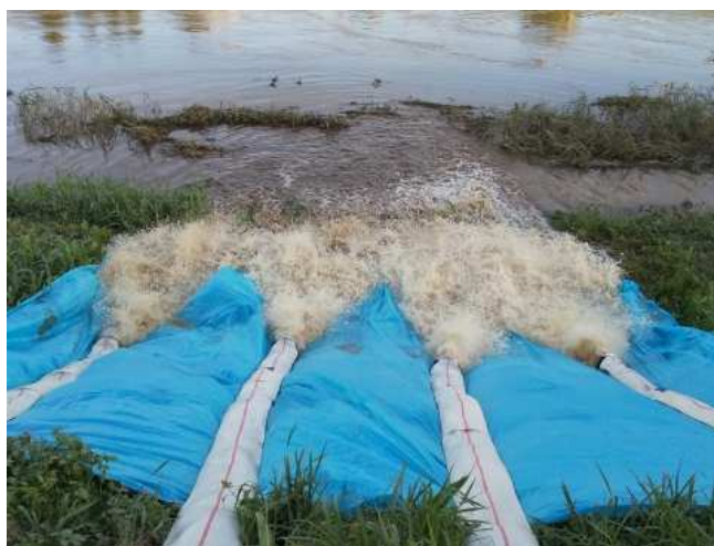
排水状況(川表) 10月13日午後
