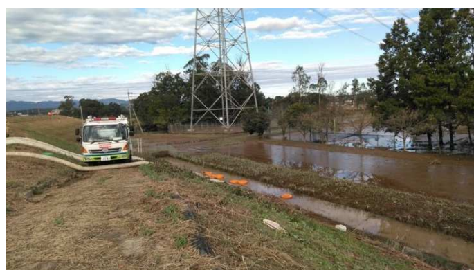
排水後(川裏) 10月15日午前
