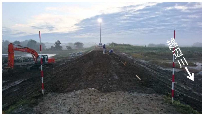
2019.10.20 8時00分時点 堤防盛土
