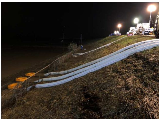
排水状況(川裏) 10月14日午後
