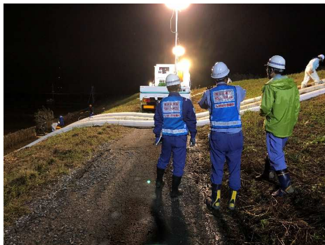
排水ポンプ車の展開状況 10月14日午後
