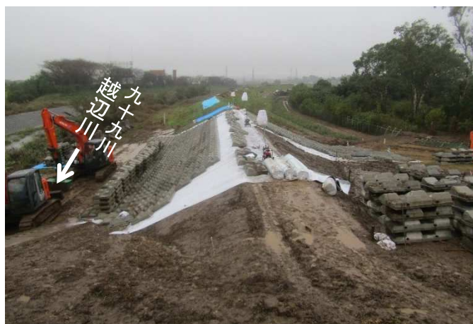
2019.10.19 8時00分時点 大型連節ブロック張施工中
