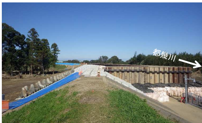
2019.11.8 13時00分時点 緊急復旧工事完了
