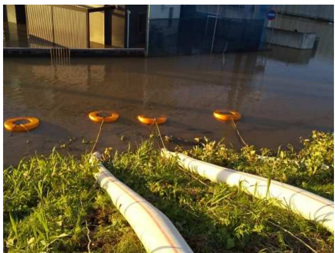
排水状況(川裏) 10月13日午後
