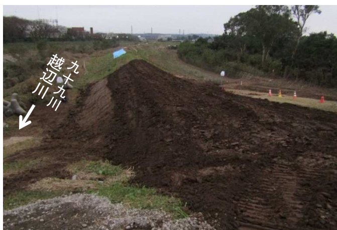
2019.10.17 8時00分時点 堤防盛土
