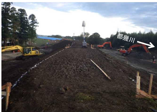
2019.10.20 8時00分時点 堤防盛土
