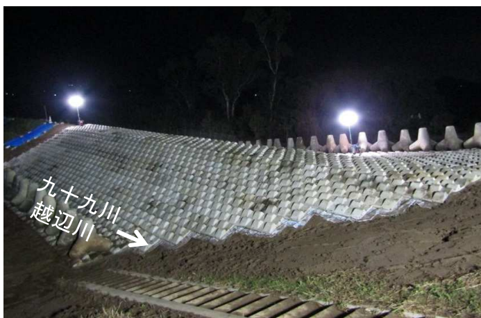
2019.10.19 21時20分時点 緊急復旧工事完了
