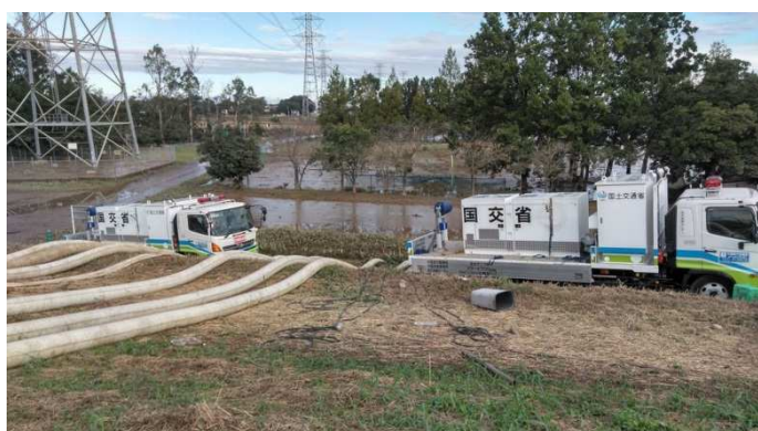
排水ポンプ車設置状況 10月15日午前
