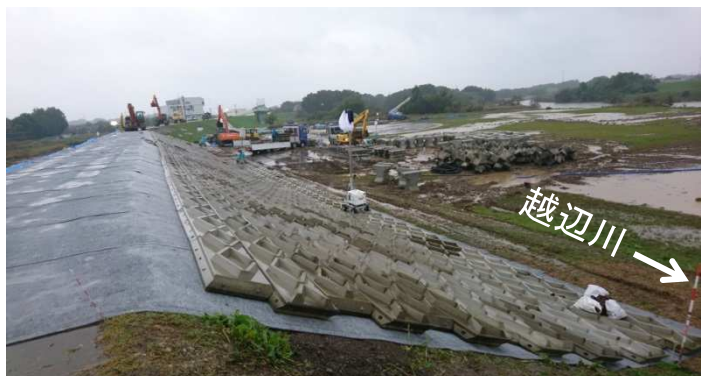
2019.10.22 8時00分時点 連節ブロック張施工中
