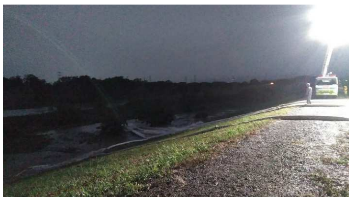
排水状況(川表) 10月14日午後
