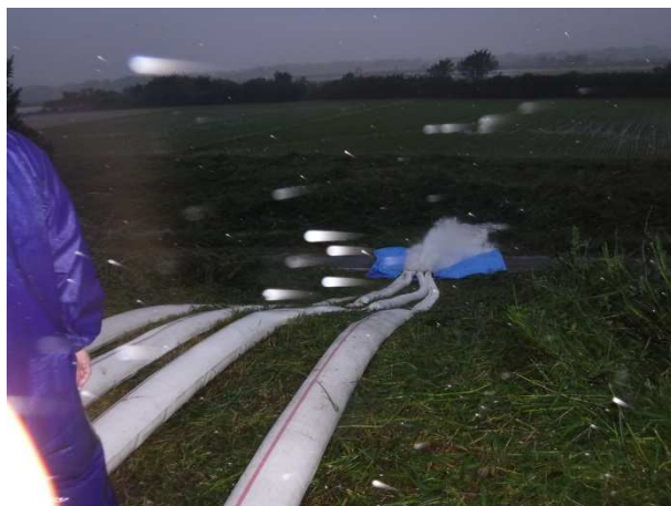
排水状況(川表) 10月12日午後
