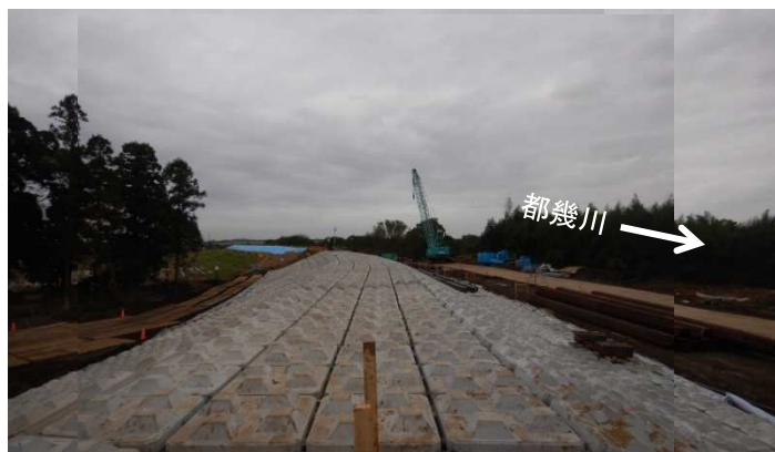
2019.10.24 8時00分時点 大型連結ブロック施工完了
