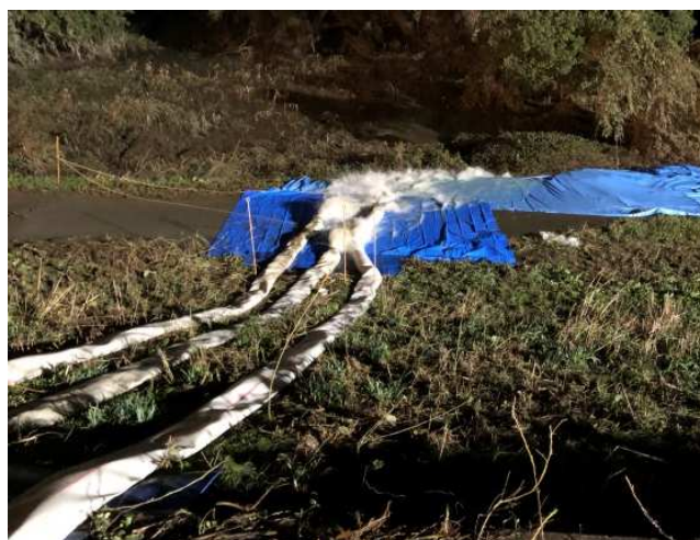
排水状況(川表) 10月14日午後
