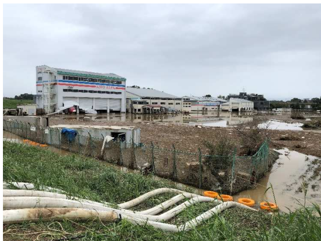
排水状況（川裏） 10月14日午前
