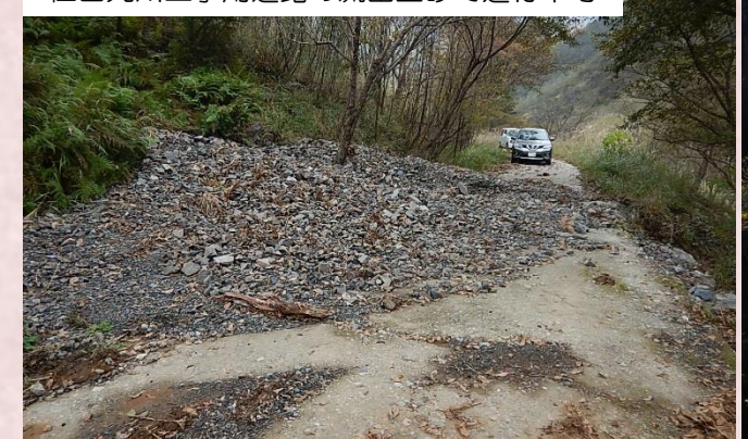
仁田元川工事用道路の流出土砂で通行不可
