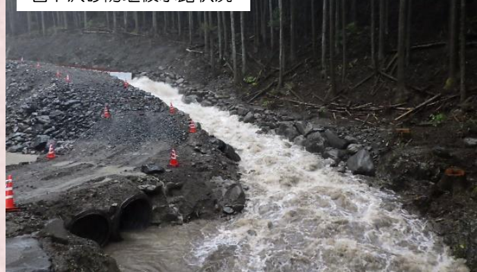
岩下沢砂防堰仮水路状況
