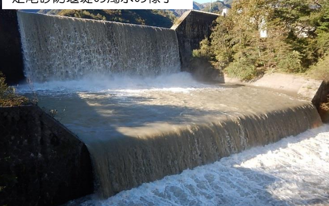
足尾砂防堰堤の濁水の様子
