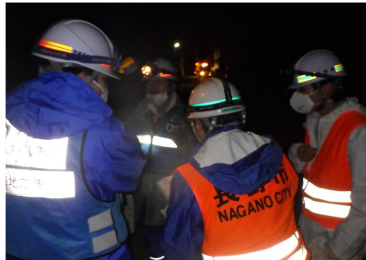
路面清掃について現地打合(長野県長野市)
