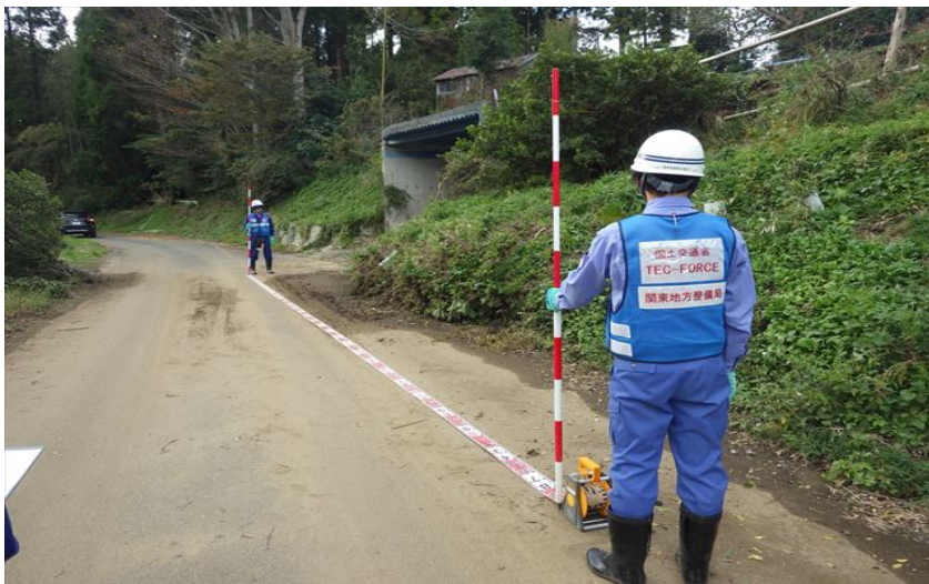
長柄町内の被災箇所現地調査
