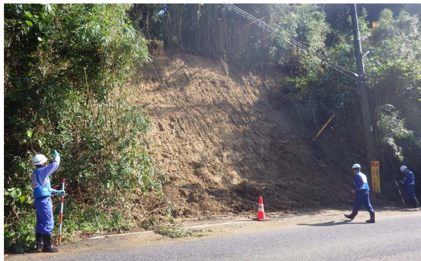
長柄町内の被災箇所現地調査
